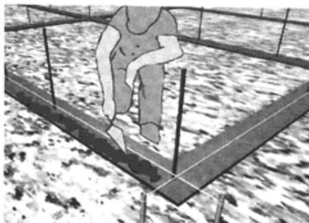
Figura 45. Colocación del mortero sobre el cimiento
